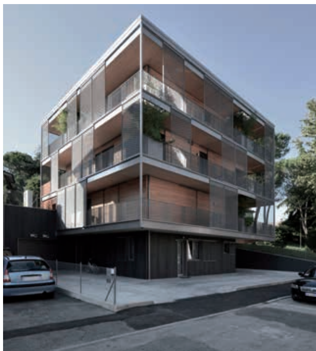
Passive House a destinazione multi-residenziale, costruita in legno con struttura in pannelli di CLT, www.fioritapassivehouse.it .
